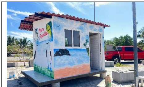
Imagen 01. Construcción de caseta de cobro
