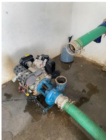
Figura 05. Mantenimiento de bomba instalada en caseta de bombeo de laguna de lixiviados
