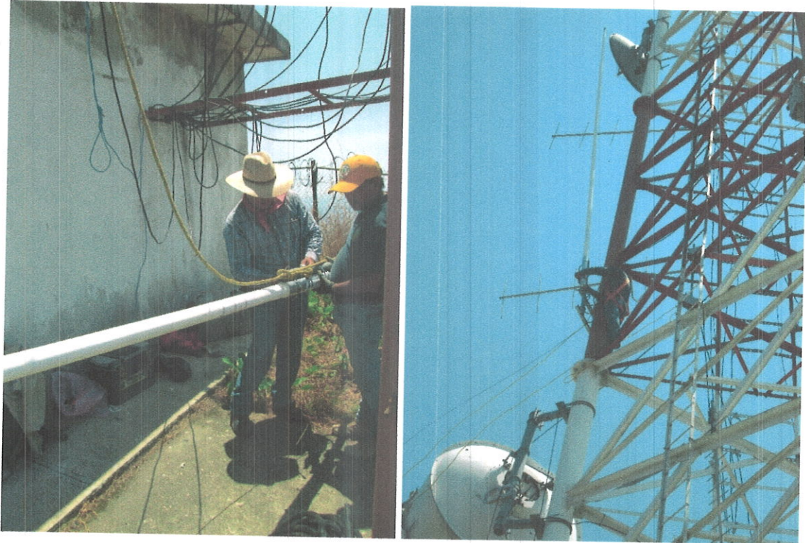
Durante instalación de soporte de antena y antena.
