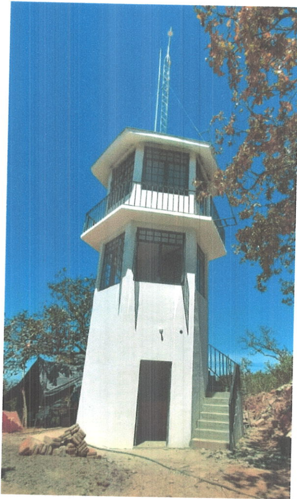
Vista de las superficies con recubrimientos en la Torre de detección.
