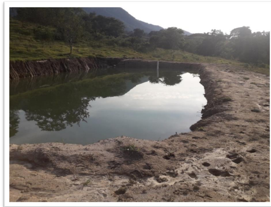
Fotografía 32. – Realización de pruebas de llenado en estanque rustico
