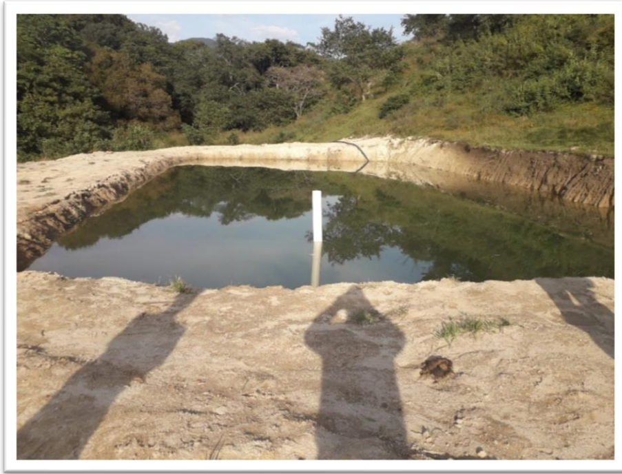
Fotografía 31. – Realización de pruebas de llenado en estanque rustico
