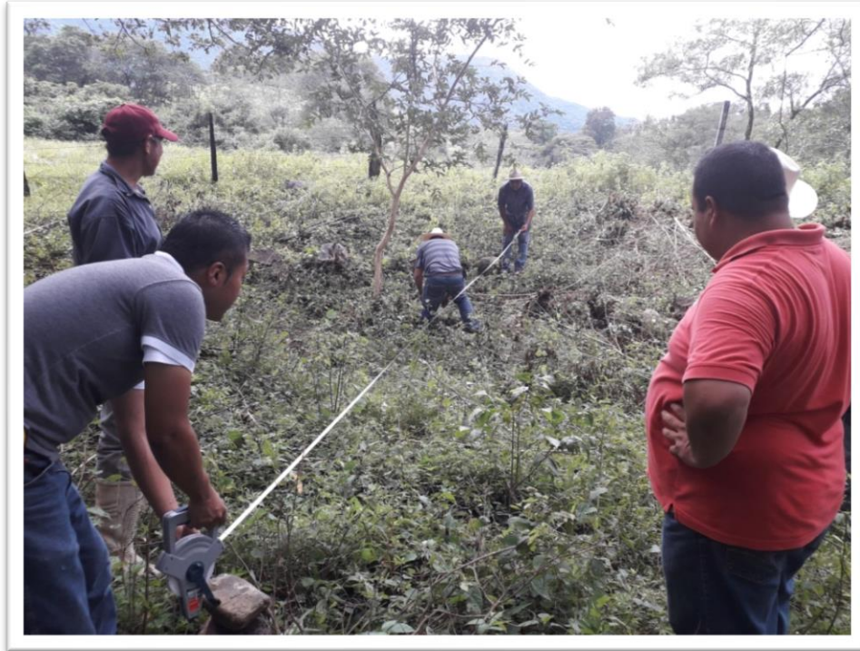
Fotografía 17.-Toma de medidas del predio donde se construirá el estanque rustico
