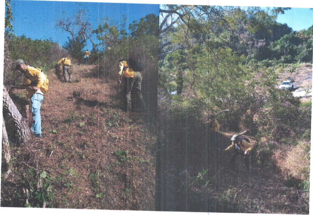
Durante las tareas de rehabilitación de brecha cortafuego en interfaz agropecuario-forestal La Culebra.
