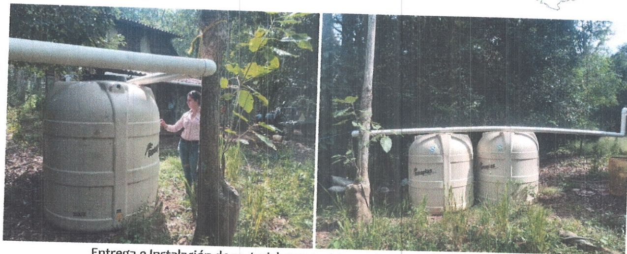
Entrega e Instalación de materiales para sistema de captación de agua pluvial
