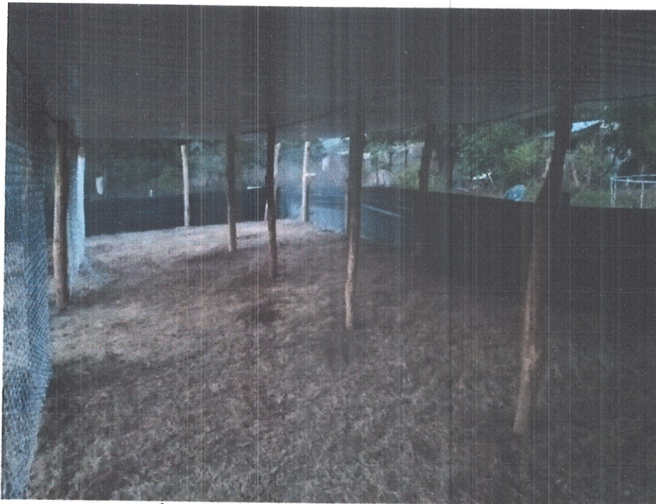
Área donde se instalará la zona de postura
