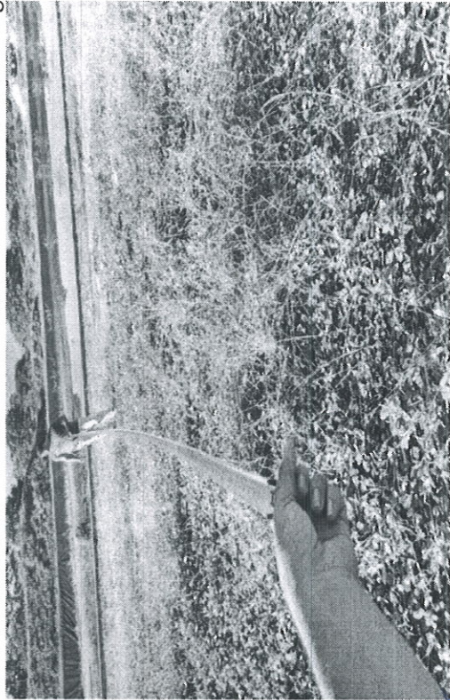
Medición de sitio y nivelación de terreno para construcción de Domo
