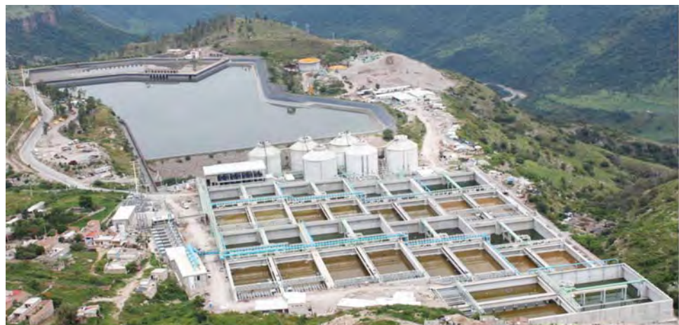
Figura. 7.30. Planta de tratamiento de aguas residuales Agua Prieta
