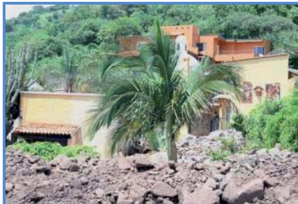
Figura 39. Daños generados por el deslizamiento más reciente sucedido el día 8 de septiembre del 2008.
