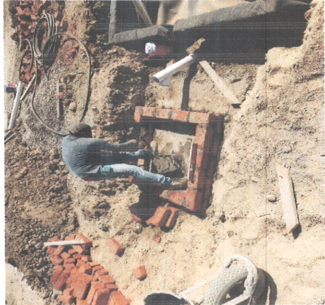
CONSTRUCCION DE REGISTRO PARA CAPTACION DE LIXIVIADO DE HASTA UN METRO SEGUN DISENO, INCLUYE: MATERIALES, MANO DE OBRA.
